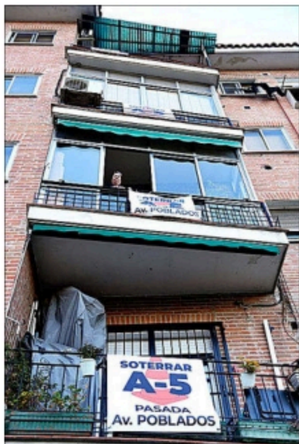
Uno de los edificios afectados. J. BARBANCHO
